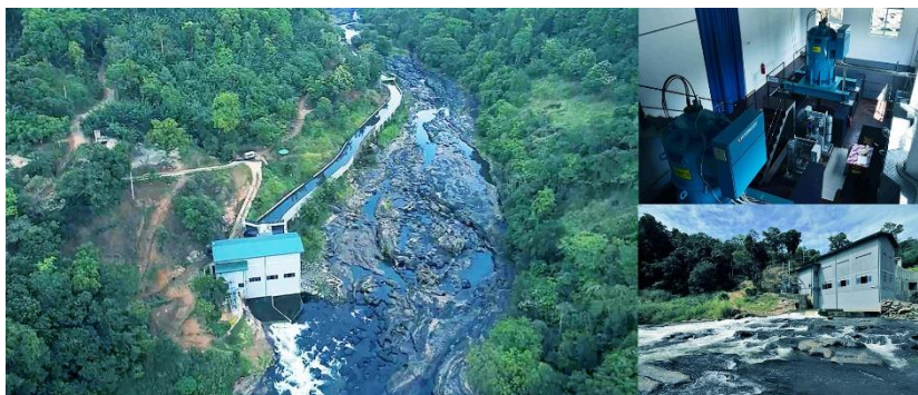
Hapugahakumbura 水力発電所 (Sri Lanka/Sabaragamua 州): フィジビリティスタディの実施後、コンソーシアム参画企業において開発、事業化が実現したミニ水力発電所
